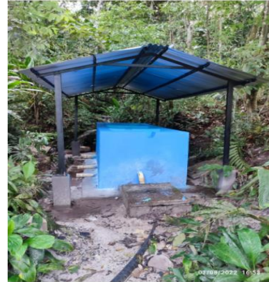
Mantenimiento tanque desarenador Bocatoma caño cristal
