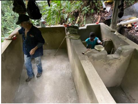
Obras intervención en tanque de almacenamiento bocatoma caño lozano
