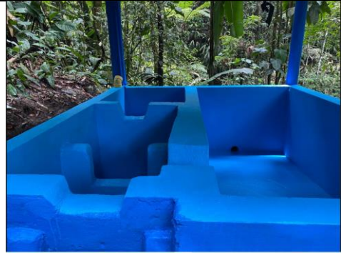
Estado del tanque y caseta
