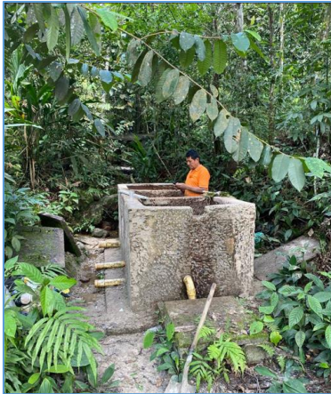
Mantenimiento tanque desarenador Bocatoma caño cristal
